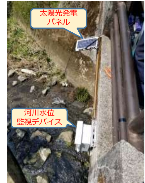
現場設置事例
