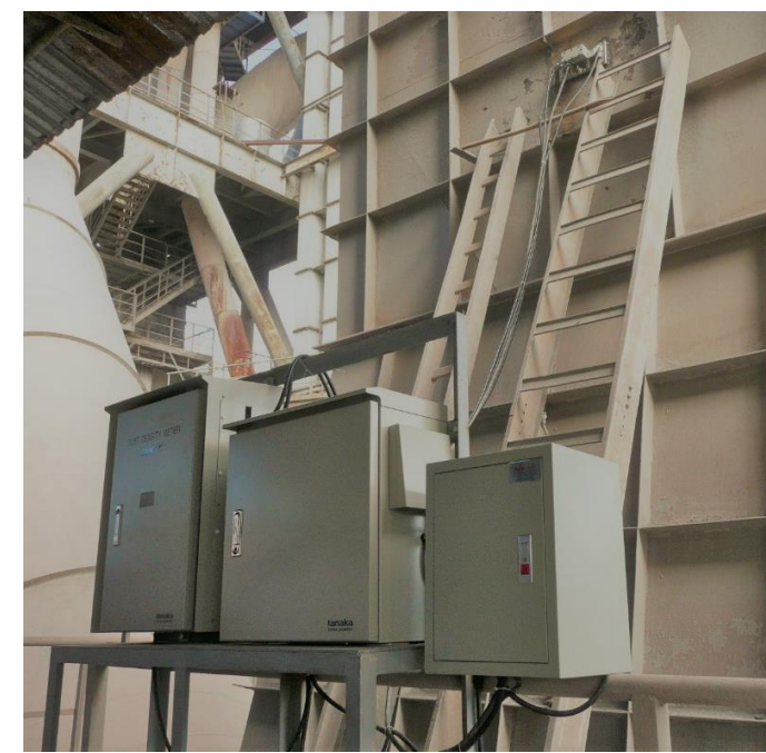
ダスト濃度計設置工事完了
