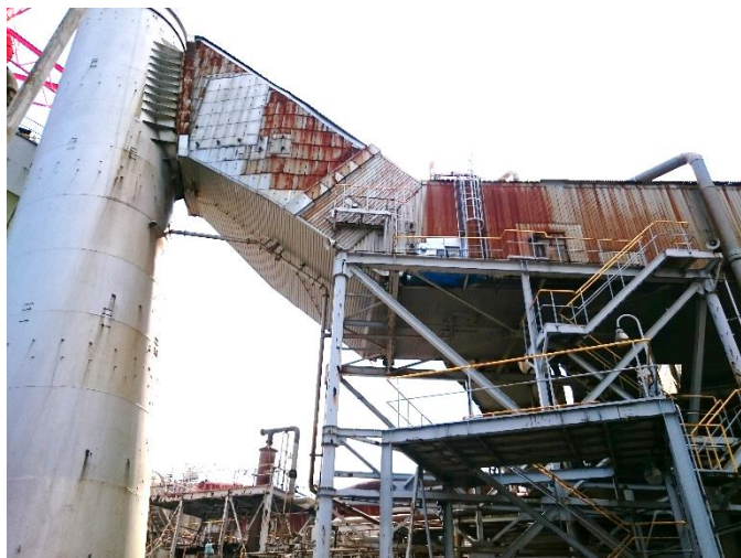
白煙を排出する煙突に繋がる煙道(ダクト)
