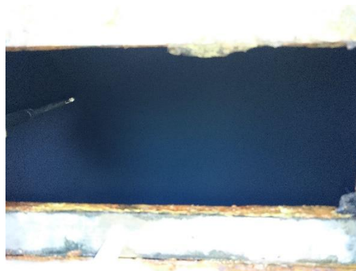
ダクト1カ所に穴あけ工事(排ガスは白濁状態)
