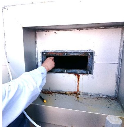
ダクト1カ所に穴あけ工事(排ガスは白濁状態)
