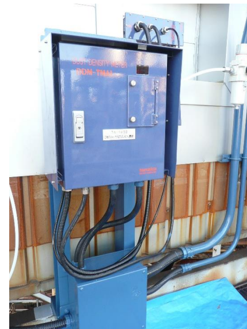
コントロールボックスへの配線・電气的確認完了
