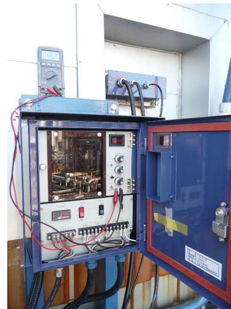
コントロールボックスへの配線・電气的確認完了
